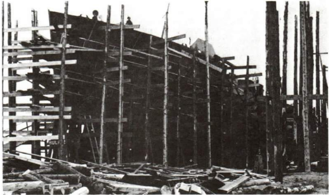
Figure 1-9 Corvette Under Construction Une corvette en chantier
