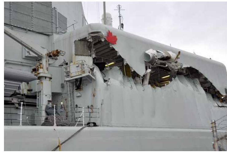
Endommagé par HMCS Protecteur lors d'un exercice
